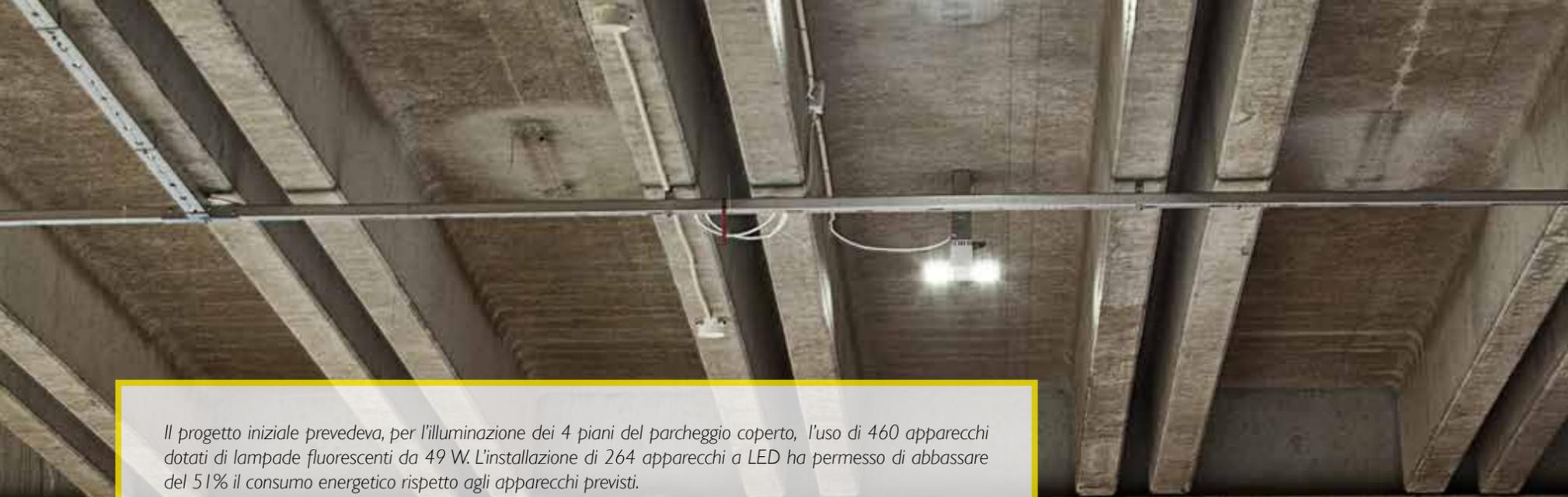
Il progetto iniziale prevedeva, per l'illuminazione dei 4 piani del parcheggio coperto, l'uso di 460 apparecchi dotati di lampade fluorescenti da 49 W. L'installazione di 264 apparecchi a LED ha permesso di abbassare del 51% il consumo energetico rispetto agli apparecchi previsti.
